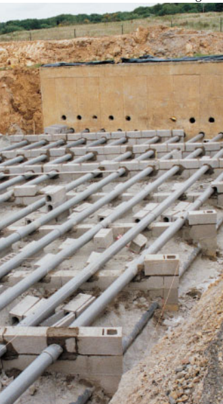
Entrée d'air de l'échangeur
