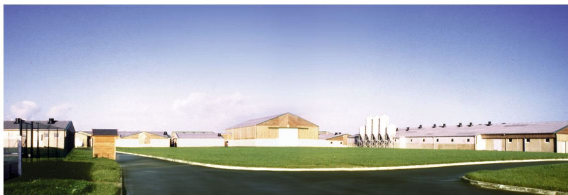
Station de Romillé
